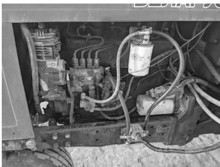
Рис. 2. Установка измерительного прибора DFM-100AK в системе питания двигателя внутреннего сгорания МТЗ-80Х в лабораторных условиях
